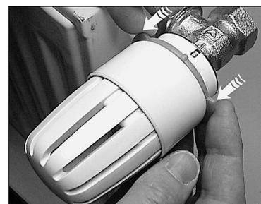
Антиблокировочный ключ до упора задвинуть в зазор между зубчатым кольцом ② и обечайкой ③ согласно рисунка.
