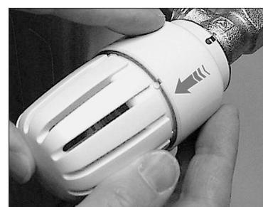
Обечайку ③ сдвинуть в направлении от клапана до тех пор, пока шкала маховика не будет закрыта. Желаемая температура установлена. Повернуть зубчатое кольцо, закрыв отверстие в гайке.
